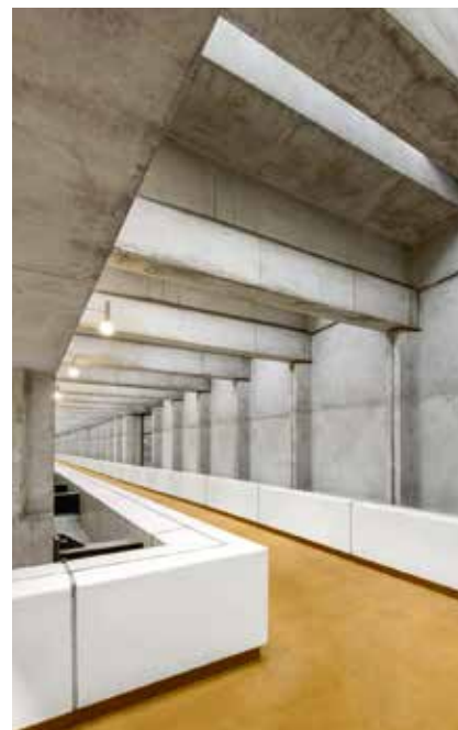
Usine de Pessac Pessac Plant
