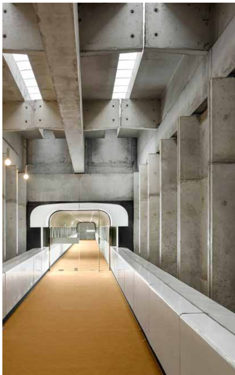
— Usine de Pessac Pessac plant
