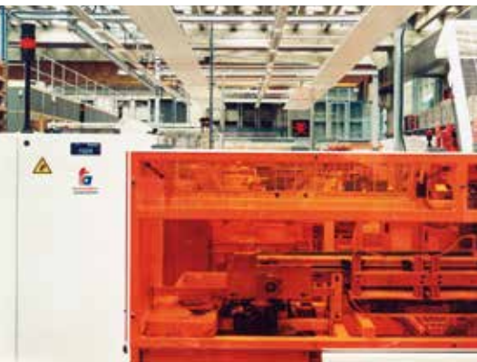
Usine de Pessac Pessac plant
