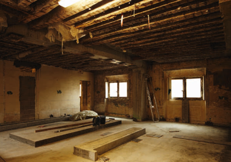
Chantier MétaMorphoses : cuisines du restaurant du chef étoilé Guy Savoy
