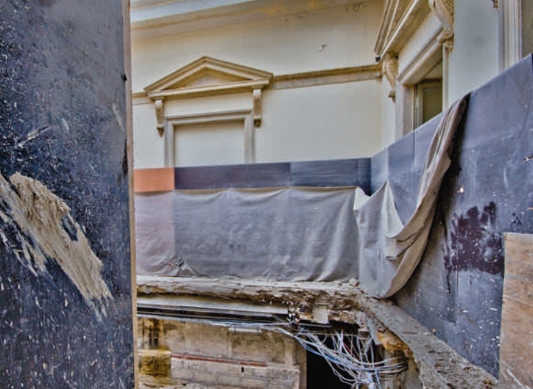
Chantier MétaLmorphoses : Petit Monnayage
