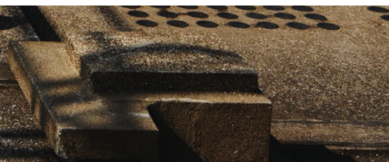
Chantier MétaLmorphoses : Palais toit ouest MétaLmorphoses site: roof of west wing
