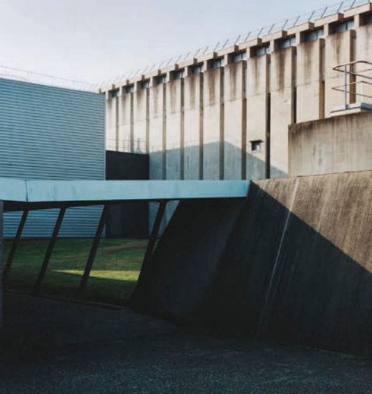
Usine de Pessac Pessac factory
